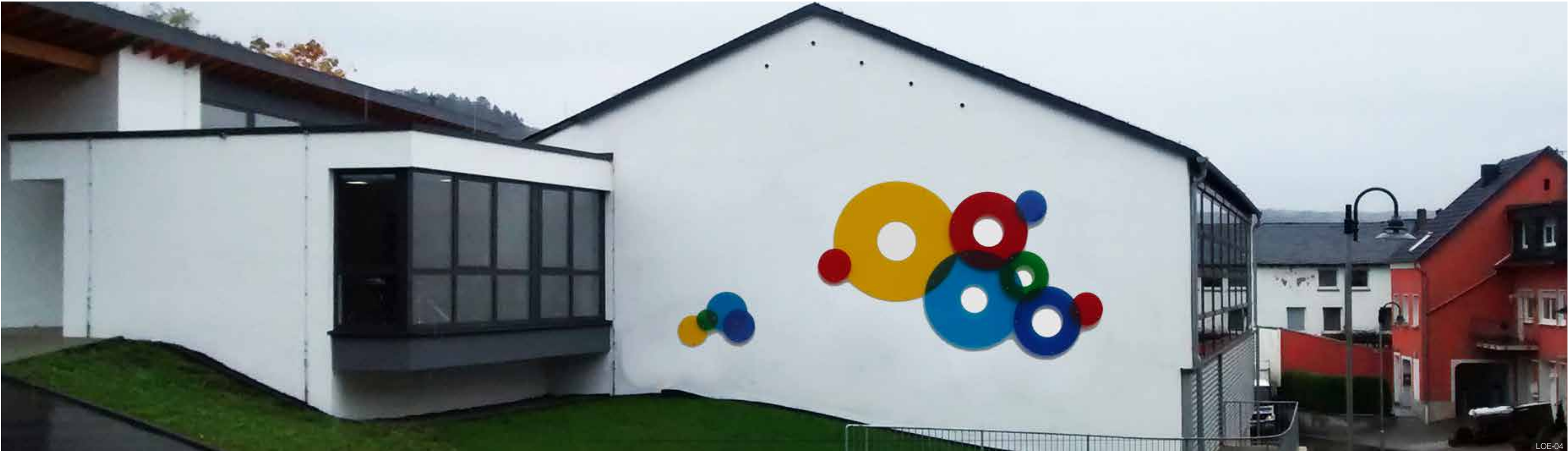
Grundschule Nittel, 2015 Installation von runden Glas- objekten aus transluzentem, witterungsbeständigem Acryl. Montage in 15-20 cm Abstand von der Wand. Durch Überlap- pen entstehen neue Farben.
