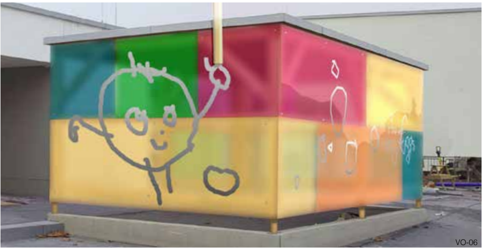
KiTa Lahneggs, Lahnstein, Entwurf für die Verkleidung der Holzkonstruktion des Abstellhäuschen mit Glas- platten (opak und translu- zent) in den sechs Farben
