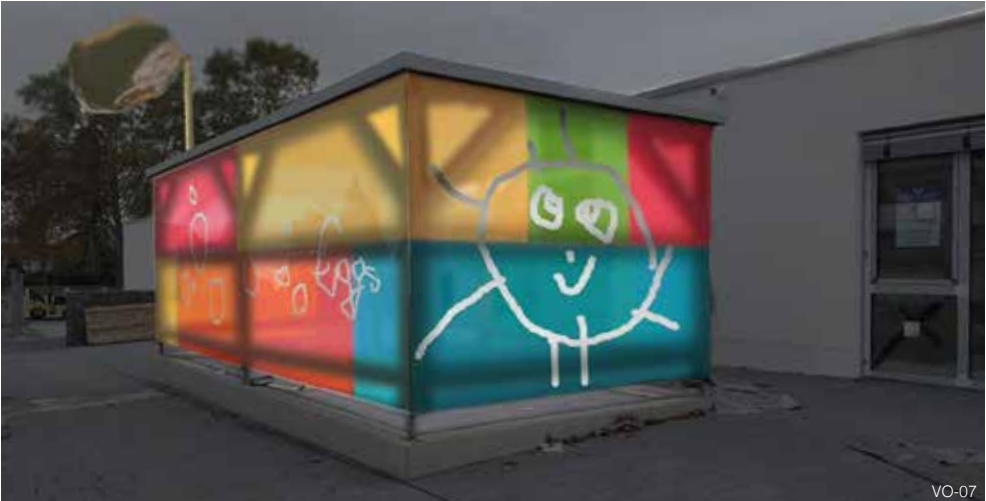
KiTa Lahneggs, Lahnstein, Entwurf für die Verkleidung der Holzkonstruktion des Abstellhäuschen mit Glas- platten (opak und translu- zent) in den sechs Farben
