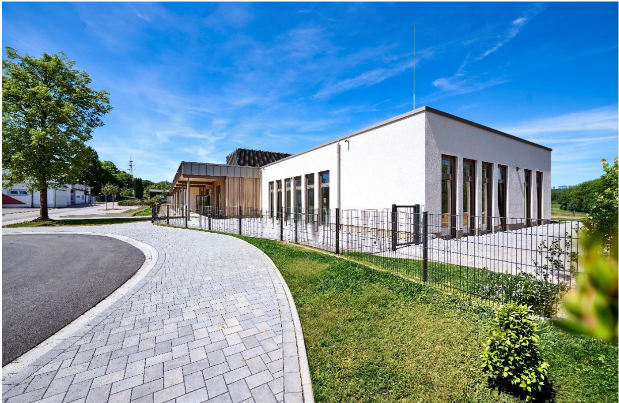
Bild 10: Außenperspektive der fertigen Kita zum besseren Gesamteindruck
