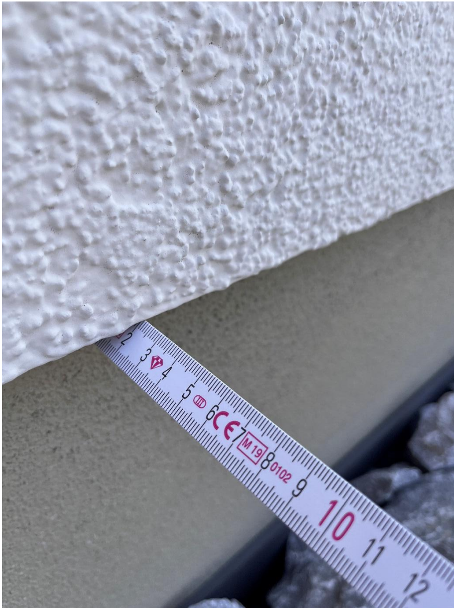
Bild 04: Sockelrücksprung zu verputzter Fassade ca. 2,5 cm
