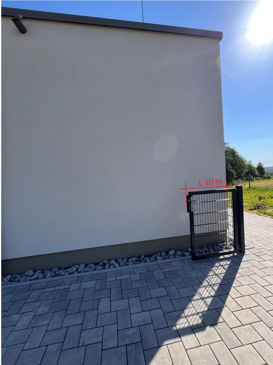
Bild 06: Tür von Zaunanlage öffnet in die Wandfläche hinein. Torbreite ca. 0,95 m. Ragt rund 1,10m in die Fläche hinein.
