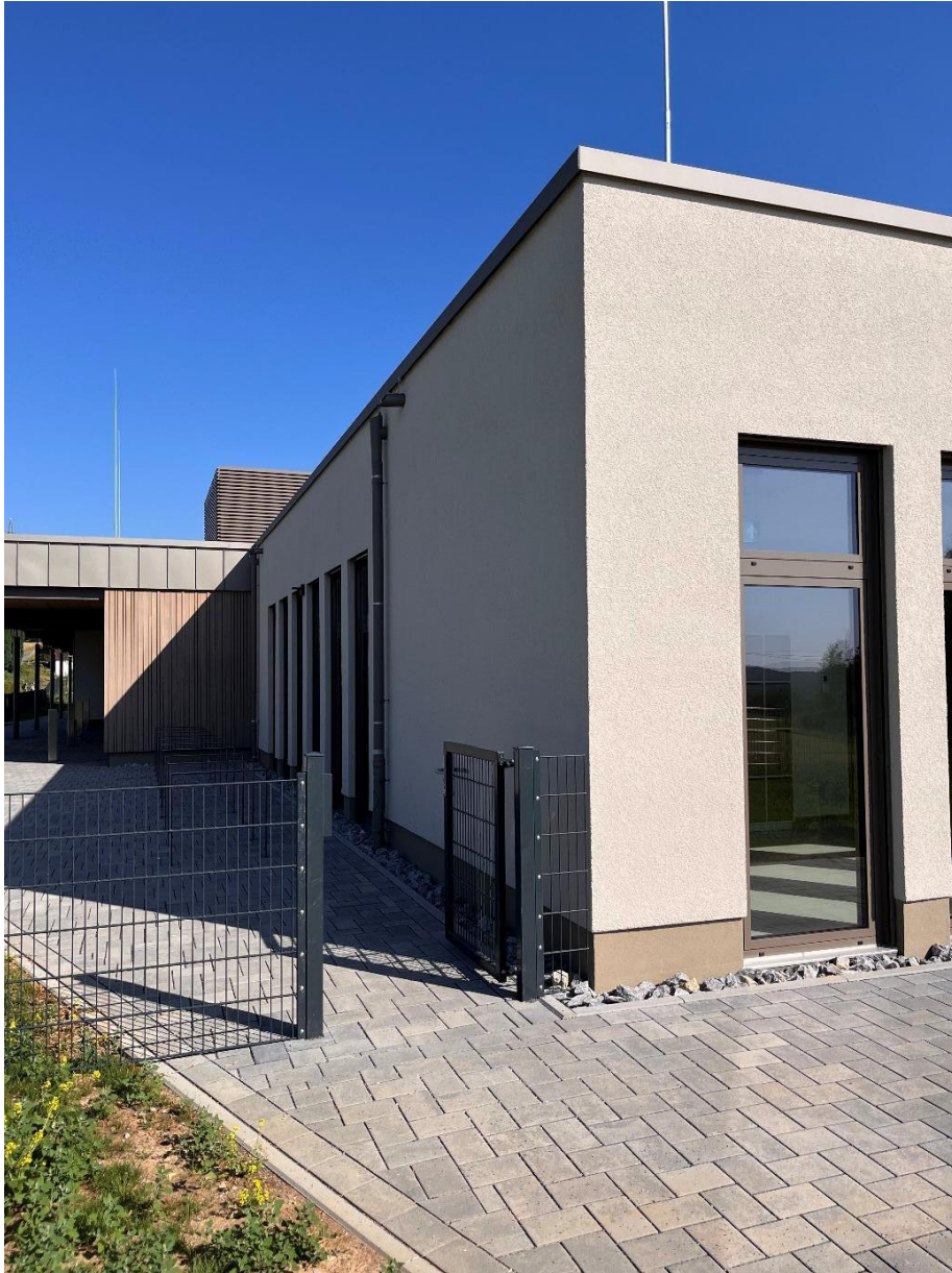
Bild 09: Wandfläche Südwest mit flankierender Wandseite Südost
