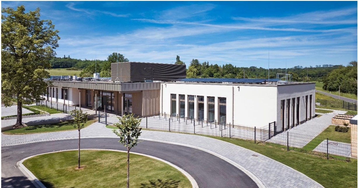
Bild 11: Außenperspektive der fertigen Kita zum besseren Gesamteindruck
