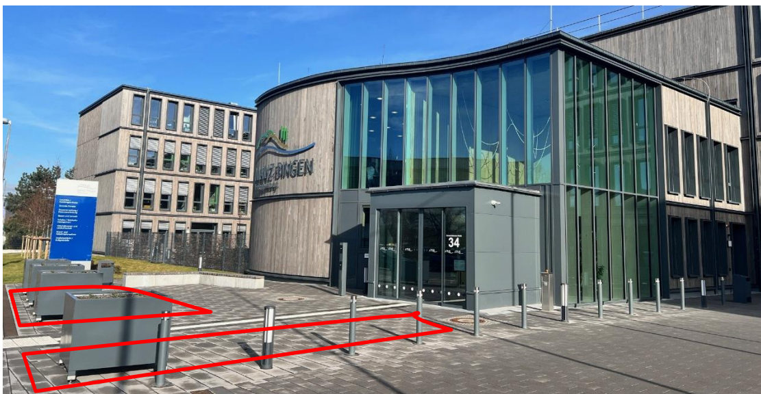
Blick von Zufahrt auf Bauteil A/Haupteingang
