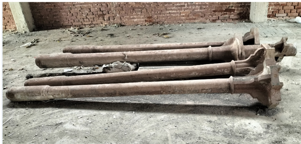
Gussstützen aus dem Mannschaftsgebäude
