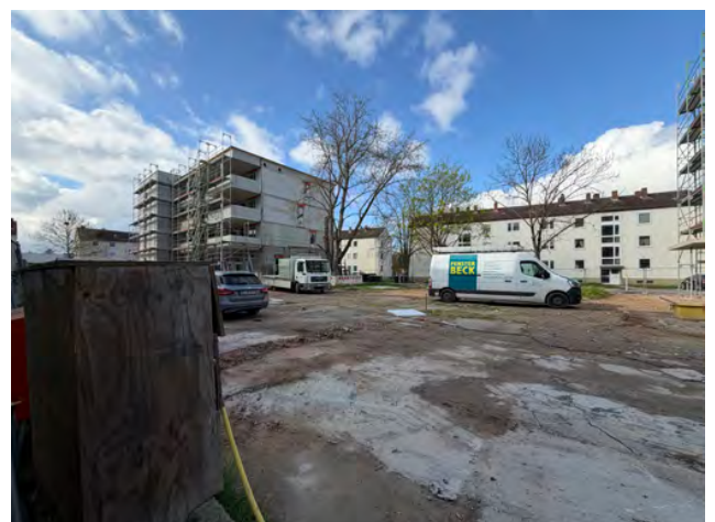
Gebäude C Blick von Quartiersplatz auf Stirnseitige Fassade
