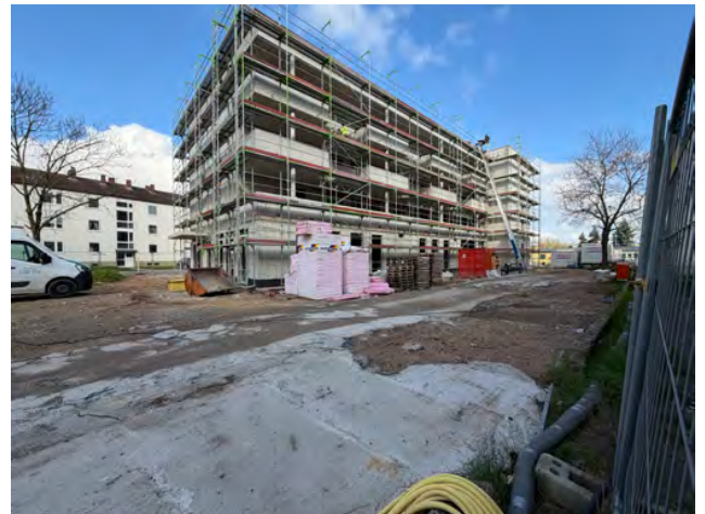
Gebäude B Blick von Quartiersplatz auf Stirnseitige Fassade
